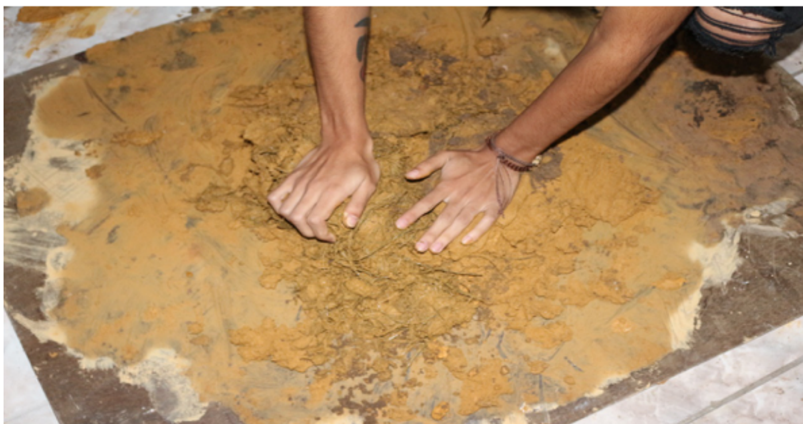
Figura 7: Argila sendo amassada com a fibra do capim. Fonte: Bittencourt; Silva.
