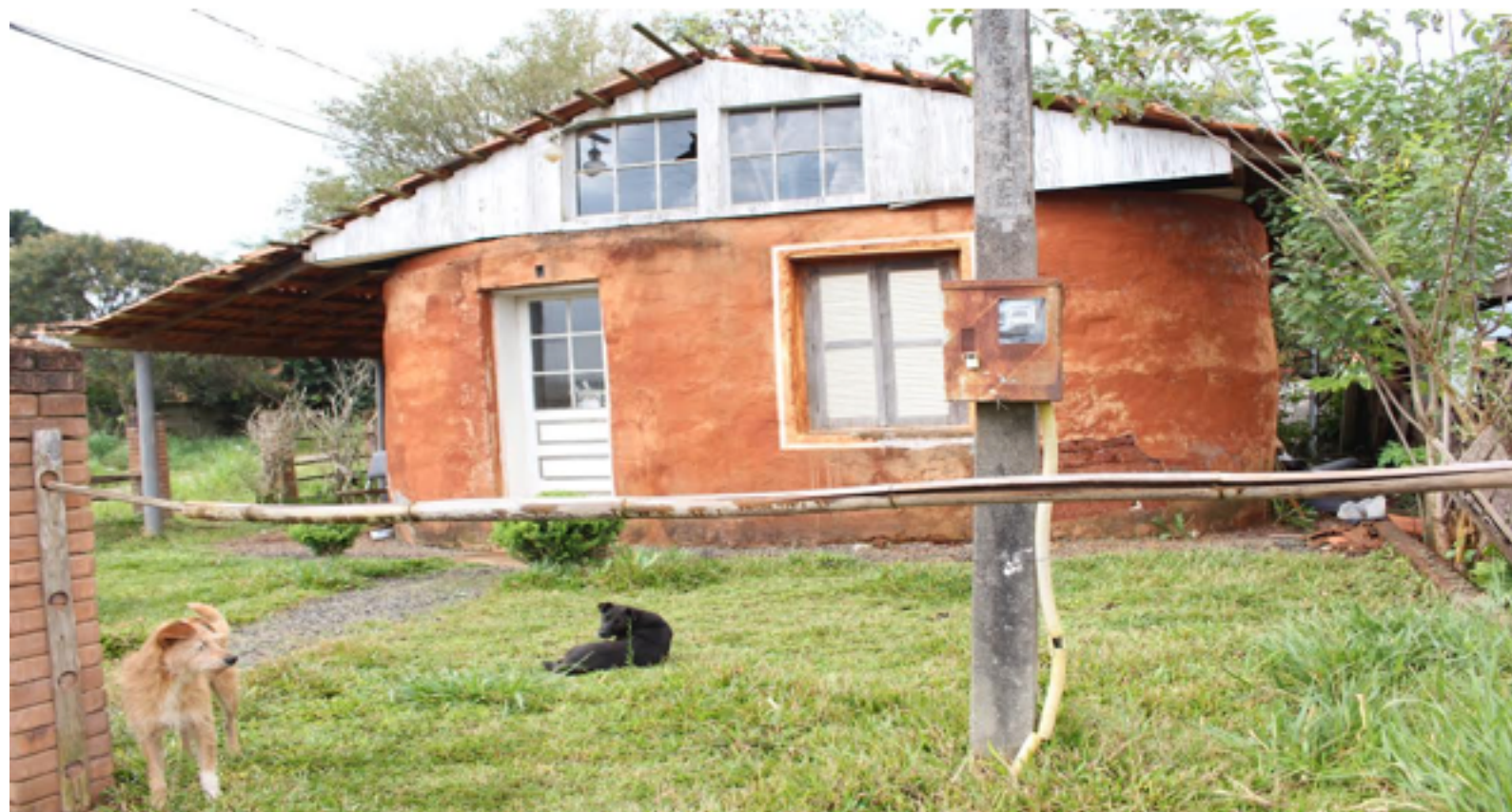
Figura 1: Casa de Superadobe da dona Amanda Souza, nos Campos Gerais. Fonte: Foto dos autores (2016) – Bittencourt; Martins; Moreno; Silva; Oliveira; Kloth; Localização: R. Dário Veloso, 1527 - Ponta Grossa, PR, Brasil.
